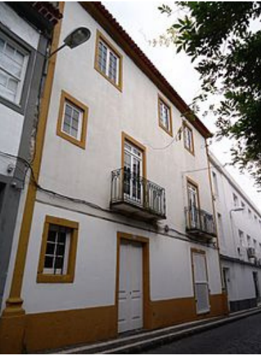
Exterior da Sinagoga
